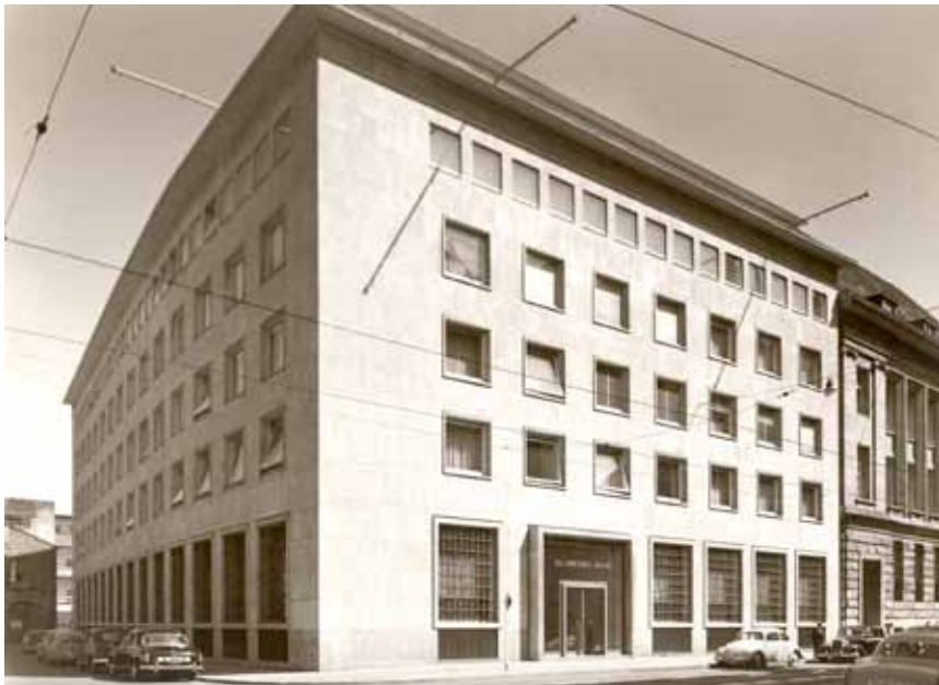
1953 bezog die Bank ihr neues Gebäude Unter Sachsenhausen 4.
