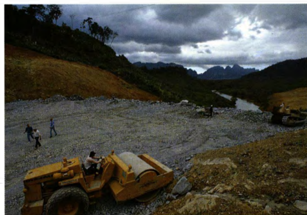
Das Staudammprojekt Chiew Larn der Electricity Generating Authority of Thailand wird mit Hilfe der Weltbank finanziert. Unsere Filiale Bangkok steht der mit der Ausführung beauftragten italienischen Baufirma mit Betriebsmittelkrediten und Garantien zur Verfügung. Filialleiter Rainer Müller (rechts) lässt sich vom Projektleiter über den Baufortschritt unterrichten.
