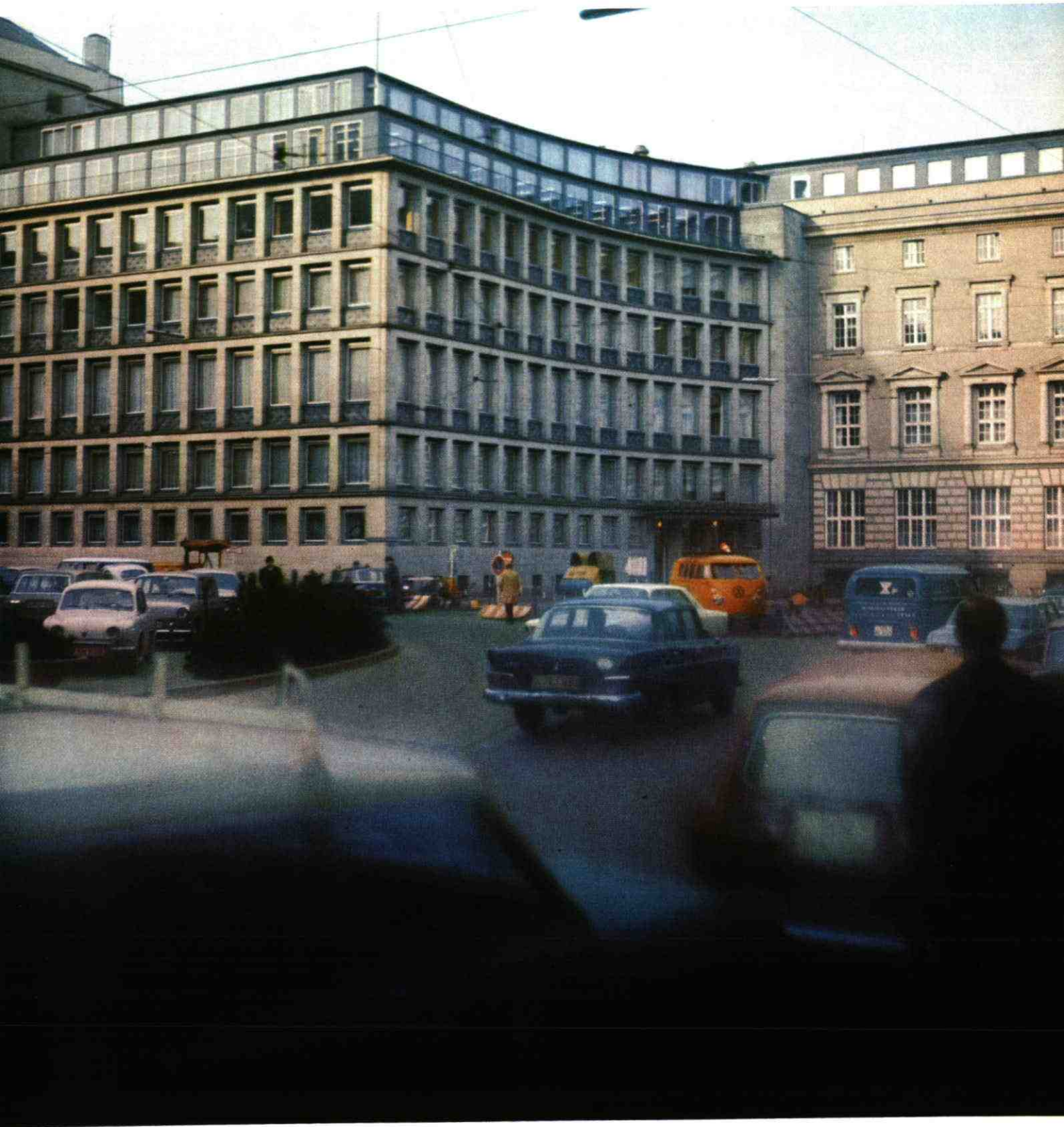
Unser Hauptgebäude in Hamburg, am Adolphsplatz – gegenüber der Börse.
