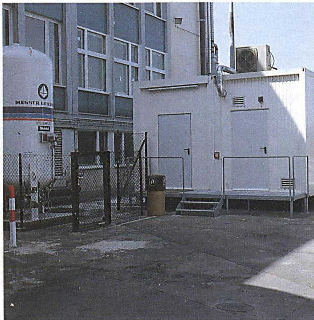
Reinraum-Container (Klasse 100) mit Anlagen zur Mikrostrukturierung stehen zum Aufbau von Mikrosensoren zur Verfügung
