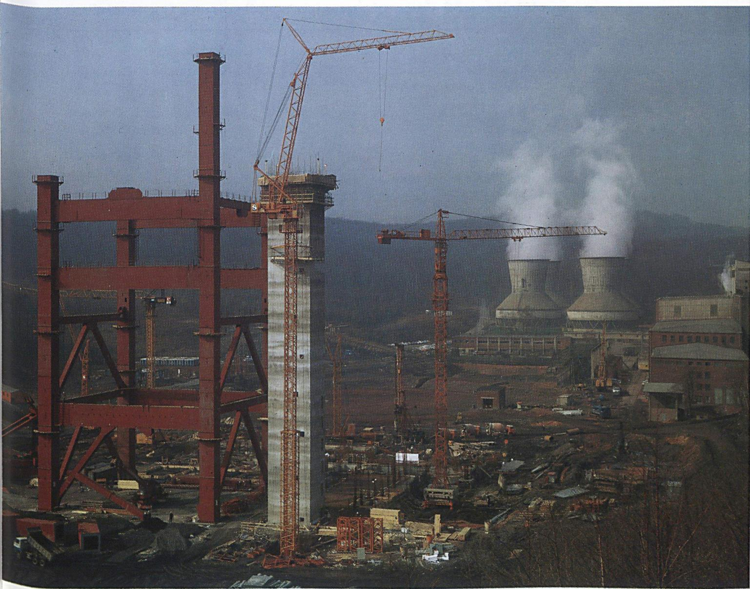
Die Saarbergwerke AG erstellen auf dem Gelände ihres Kraftwerks Weiher einen neuen 650-MW-Block. In das aus Stahlfertigteilen bestehende Kesselgerüst (links im Bild) wird der Dampfkessel eingebaut. Bei einer Leistung von rd. 2 000 t Dampf je Stunde wird der neue Kraftwerksblock jährlich etwa 1 Million t Saarkohle durchsetzen. Damit werden bestehende Arbeitsplätze im Saarbergbau gesichert und neue Arbeitsplätze im Kraftwerksbereich geschaffen.
