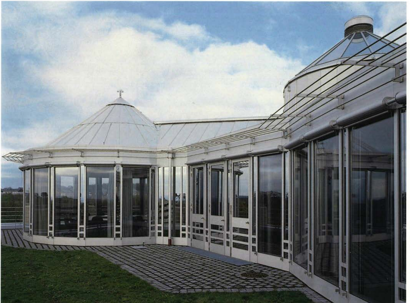
Terrasse aménagée sur le toit Dachterrasse Roof terrace
